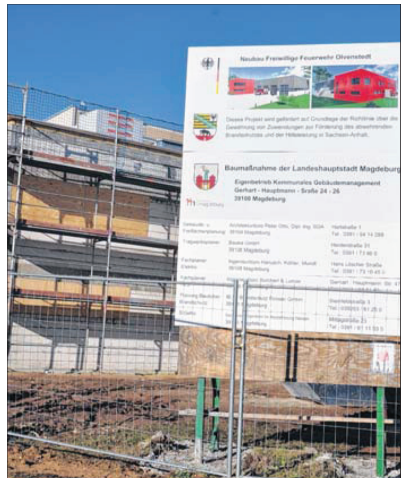
Die Außenhülle des neuen Feuerwehrgerätehauses steht, nun geht es an den Innenausbau. Foto: Marco Papritz
